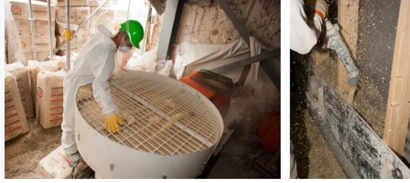
Şekil 2: Kenevir betonu; kireç, su ve kenevir talaşının ahşap iskeletli bir kalıp içerisinde sıkıştırılması ile elde edilmektedir. (URL 3- 14.01.2024 tarihinde erişilmiştir).
